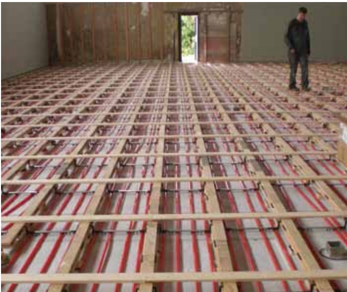
Готово смонтированная система обогрева тёплого пола для спортивных сооружений по технологии Tichelmann.
