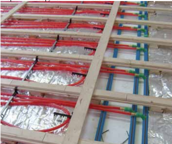
Готово смонтированная система обогрева тёплого пола для спортивных сооружений по технологии Tichelmann.
